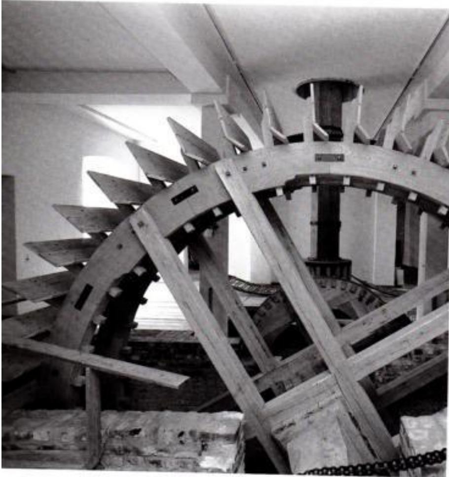
Blick auf das nach- gebaute Wasserrad und die Transmission
