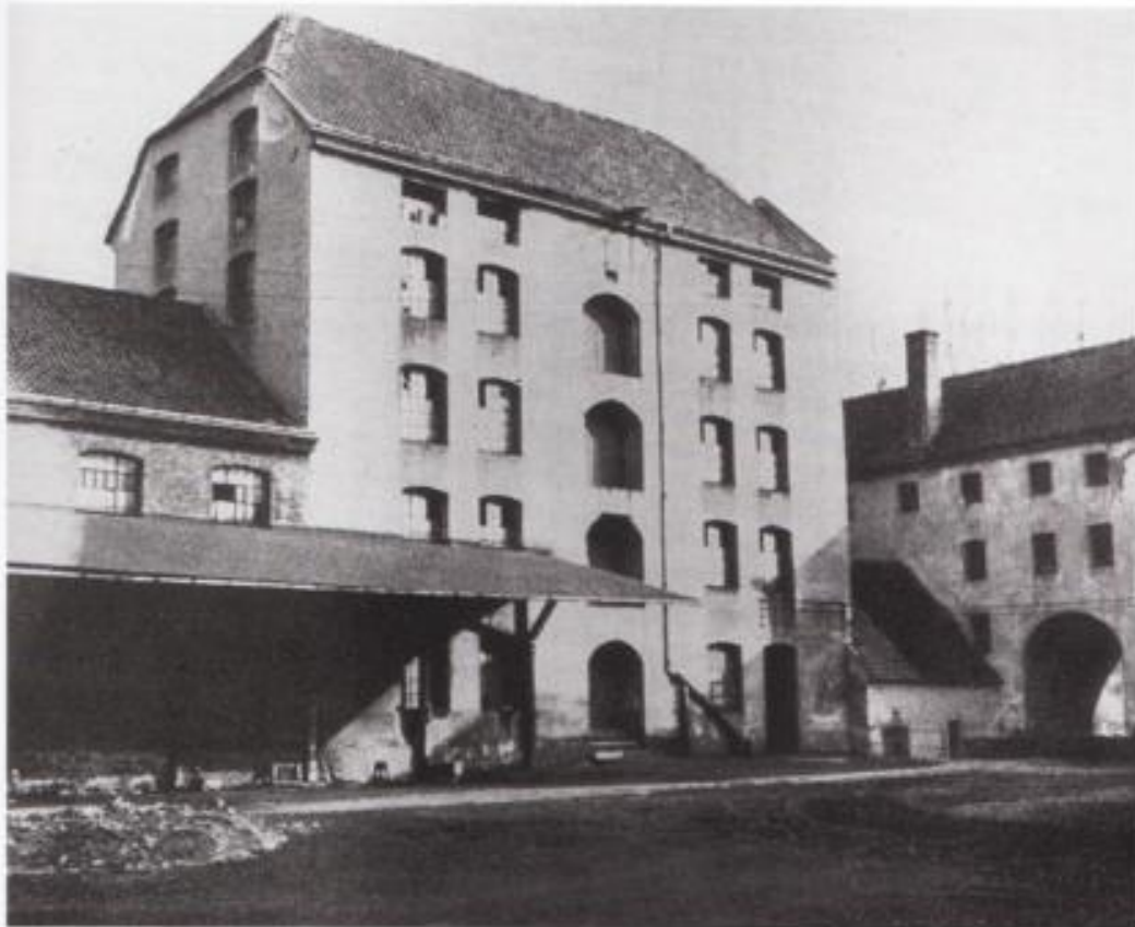
Die „Hohe Fabrik“ in Ratingen-Croimford
